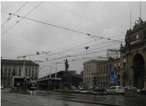
〈그림 3-125〉 취리히 중앙역 앞 트램과 자동차도로
